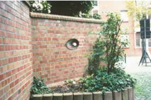
【11】 《What's behind the wall in Südstraße?》アーレン市街（ドイツ） | 1998
